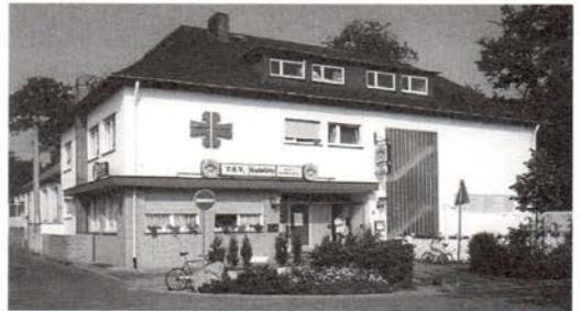
TSV Turnhalle, Aufnahme 1997
